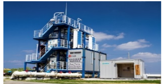
沖縄県の100kW級海洋温度差発電プラント
