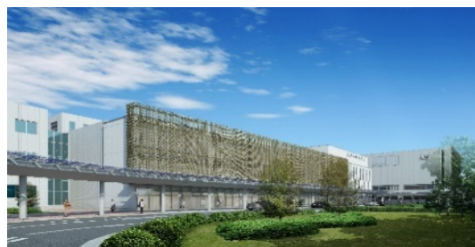
附属病院充実積立金等で整備中の附属病院
